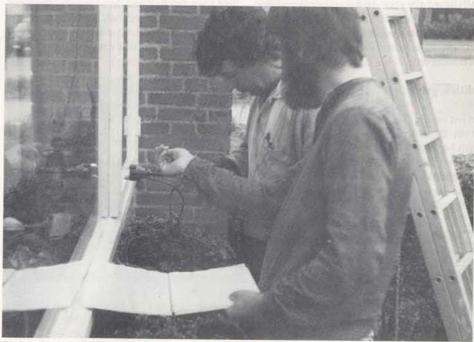
Onderzoek Bouwhulp naar rottend hout
