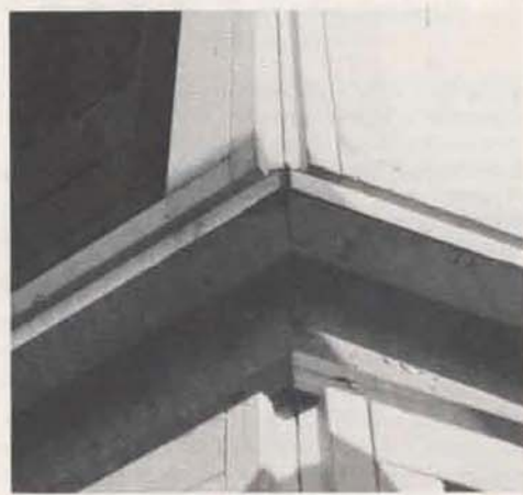
Verhoogde kans op houtrot. Extra aandacht voor verzorgen en partieel herstellen
