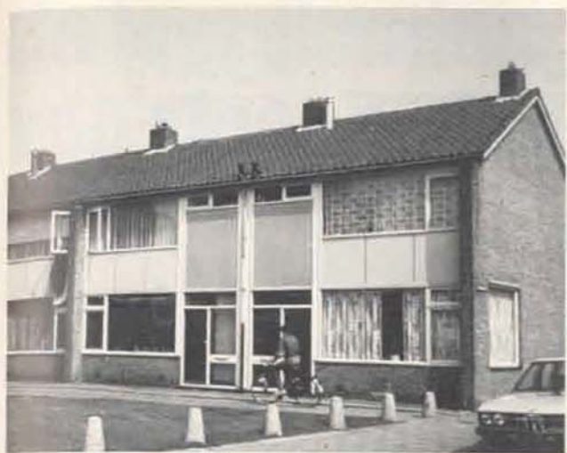
woningen in de wijk Wandelbos in Tilburg: vurehouten puilen vervangen door hardhout
