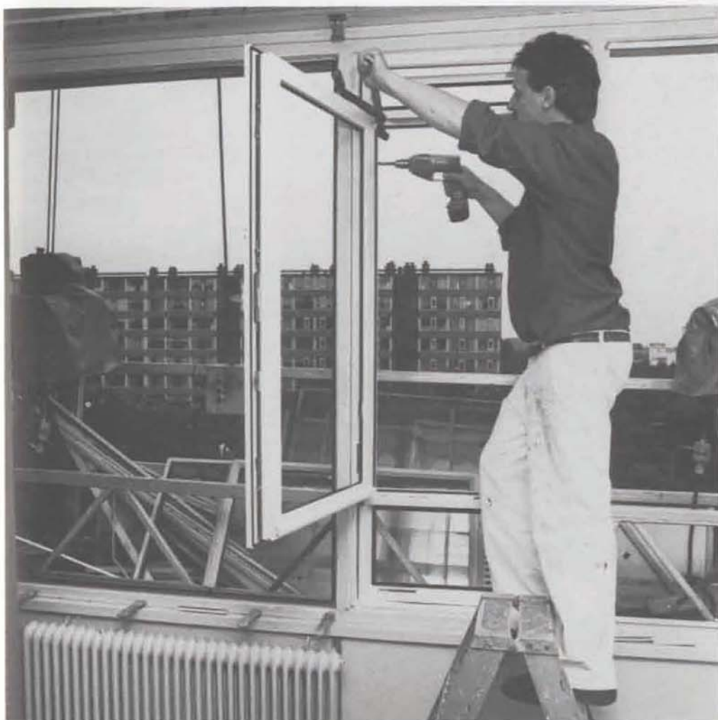
Het tien lagen hoge wooncomplex aan de Kasaldreef krijgt nieuwe kunststoframen met dubbelglas. Aan de onderzijde zijn dichte kunststofpanelen aangebracht. Dit ter vervanging van de energetisch zeer ongunstige dubbele ruit die er oorspronkelijk was.
