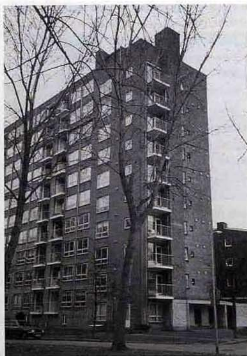
De drie torenflats in Delft-Zuid hebben een voor de jaren vijftig moderne woninguitrusting. Momenteel wordt een renovatie uitgevoerd, die nu of op termijn ruimte biedt voor een gedifferentieerde kwaliteit en aanbod.
