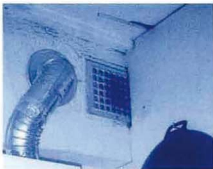
Foto 3: Vervuild ventilatiekanaal
