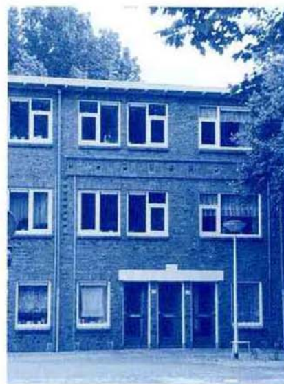
Foto 3: Renovatie Wippolder te Delft.
