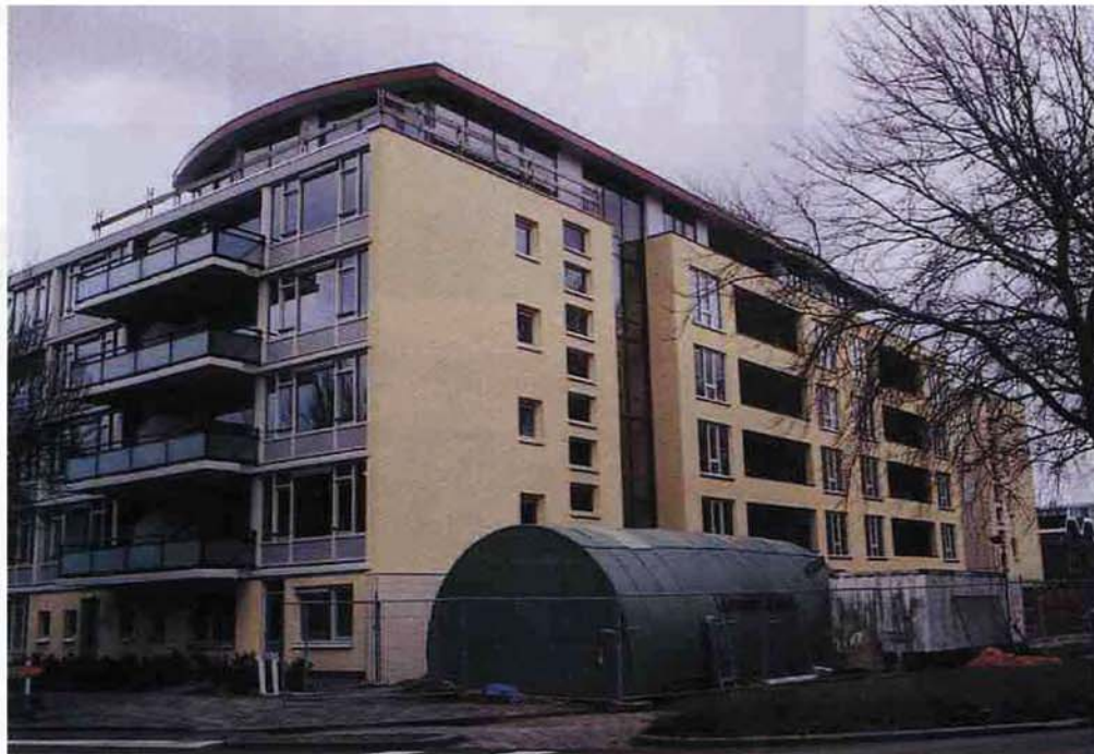
Oud en nieuw ontmoeten elkaar: het bestaande blok 5 en het nieuw gebouwde blok D met hun gemeenschappelijk trappenhuis. Boven op blok 5 het penthouse dat de 24 e nieuwbouwwoning vormt.
