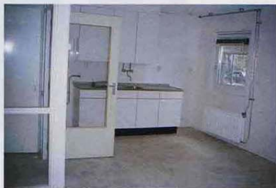
De woningen van blok 5 zijn opnieuw ingedeeld. Voor de keuken resteerde een nieuwe inrichting, evenals voor de badkamer en toilet.
