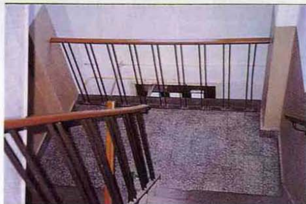
In de trappenhuizen werd naast de werkzaamheden aan de kanalen voor de mechanische ventilatie het nodige herstel- en reinigingswerk aan de betonnen trappen uitgevoerd. Ook werden de vloertegels vervangen en tot slot is het gehele trappenhuis geschilderd.
