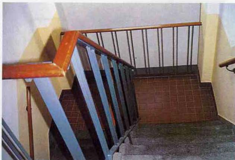
In de trappenhuizen werd naast de werkzaamheden aan de kanalen voor de mechanische ventilatie het nodige herstel- en reinigingswerk aan de betonnen trappen uitgevoerd. Ook werden de vloertegels vervangen en tot slot is het gehele trappenhuis geschilderd.
