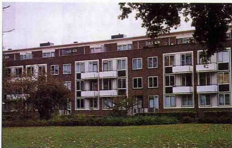
De gehele gevels zijn opgefrist door het herstellen van de betonnen delen en van het voeg- en metselwerk. Het werk werd afgerond met een schilderbeurt.
