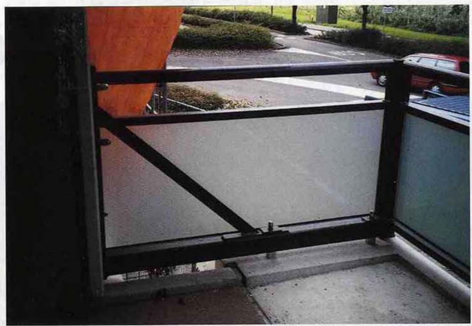
De oude balkons lagen 80 cm inpandig en waren in totaal slechts 1,35 meter diep.
