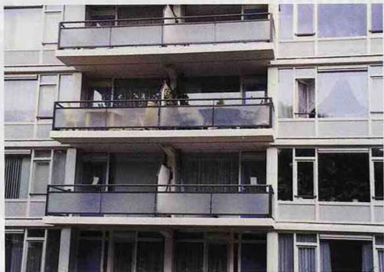
De oude balkons lagen 80 cm inpandig en waren in totaal slechts 1,35 meter diep.
