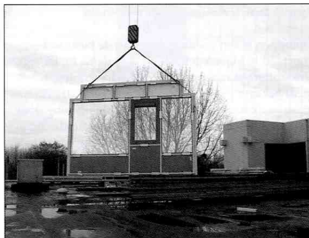
Figuur 15: Twin vliesgevel als pui monteren
