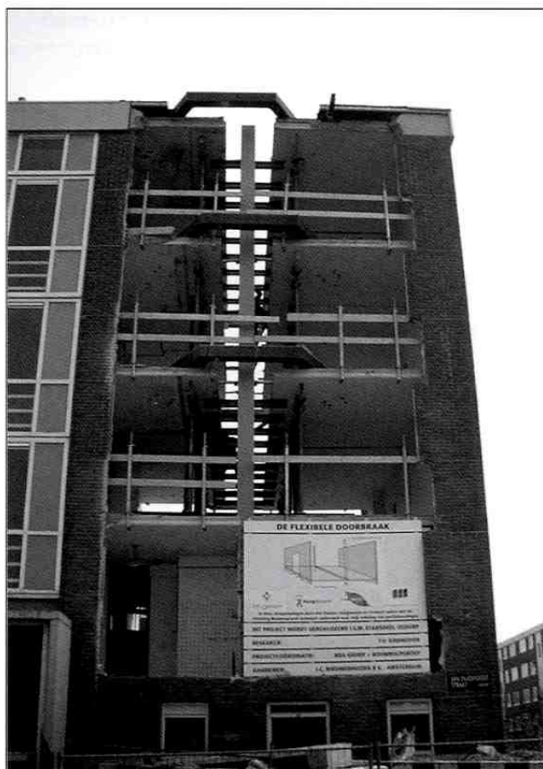
Figuur 8: Project Flexibele Doorbraak in uitvoering
