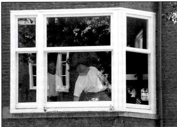
Figuur 13: Kozijnvervanging
