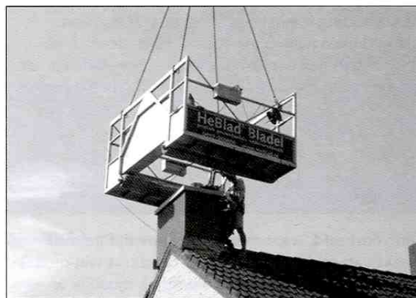
Figuur 19: Aanbrengen van een prefab schoorsteen
