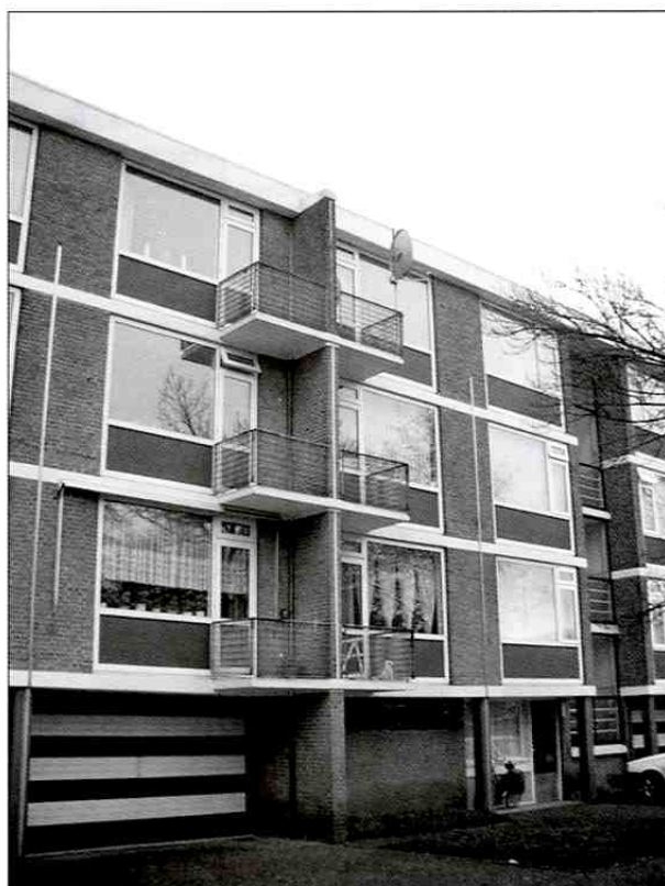
Figuur 5: Vervangen van complete puien door middel van een 2D gevel
