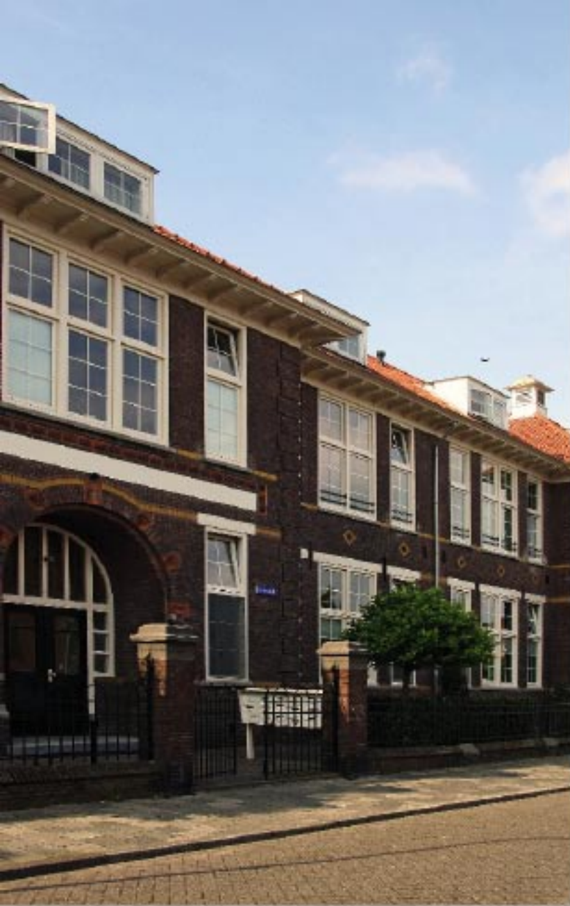
Middelbare school aan de Julianastraat in Eindhoven verbouwd tot appartementen
