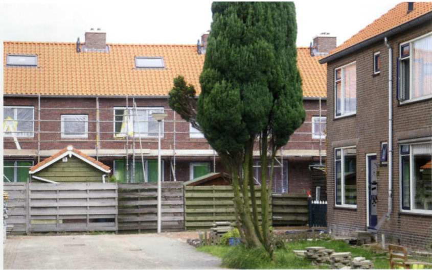
De sloop van bestaande schuttingen en schuurtjes en de bouw van gemetselde bergingen staan nog op het programma.
