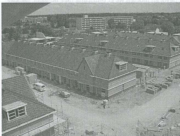
Figuur 3. Componistenbuurt te Maassluis: het aftoppen van woningen behelst het transformeren van galerijwoningen van vier woonlagen tot eengezinswoningen (foto: Panagro)
