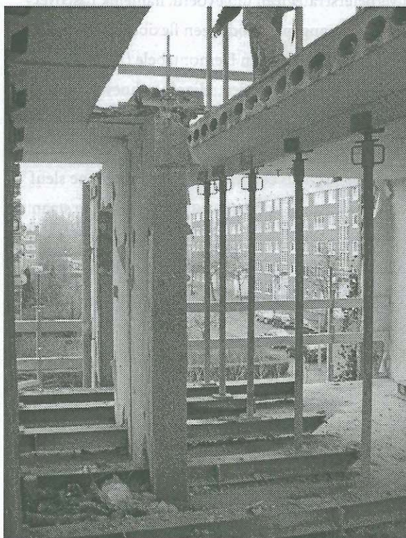
Figuur 9. De Flexibele Doorbraak: een woningscheidende wand wordt vervangen door een stalen portaal teneinde meer flexibiliteit te krijgen
