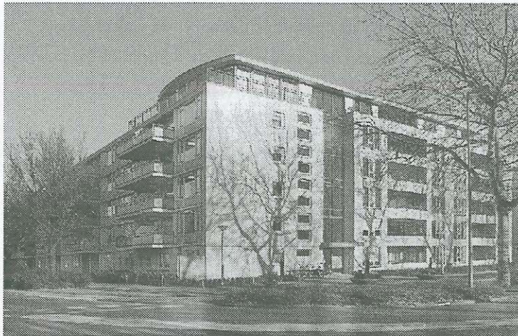
Figuur 7. Een lege plek tussen twee flats is opgevuld; oud en nieuw vormen zo samen één geheel, waarbij de voorzieningen voor beide gebouwen te gebruiken zijn
