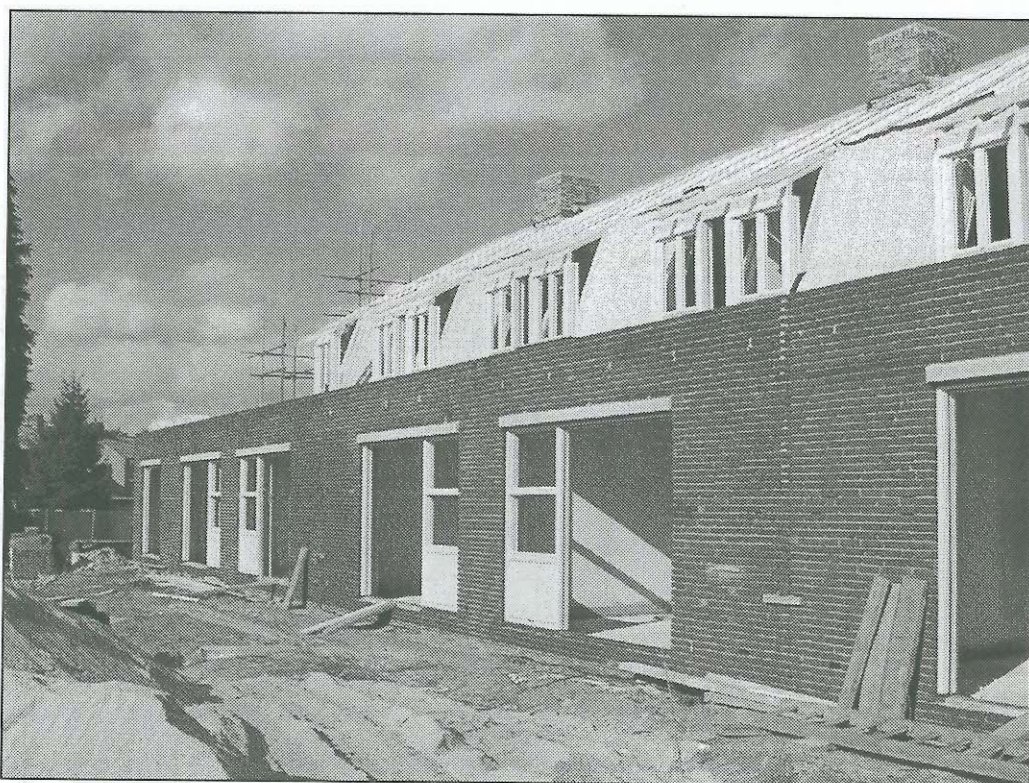
Figuur 11. De aanbouw wordt in een andere steen gerealiseerd dan de rest van het gebouw om onderscheid te maken tussen bestaand en nieuw
