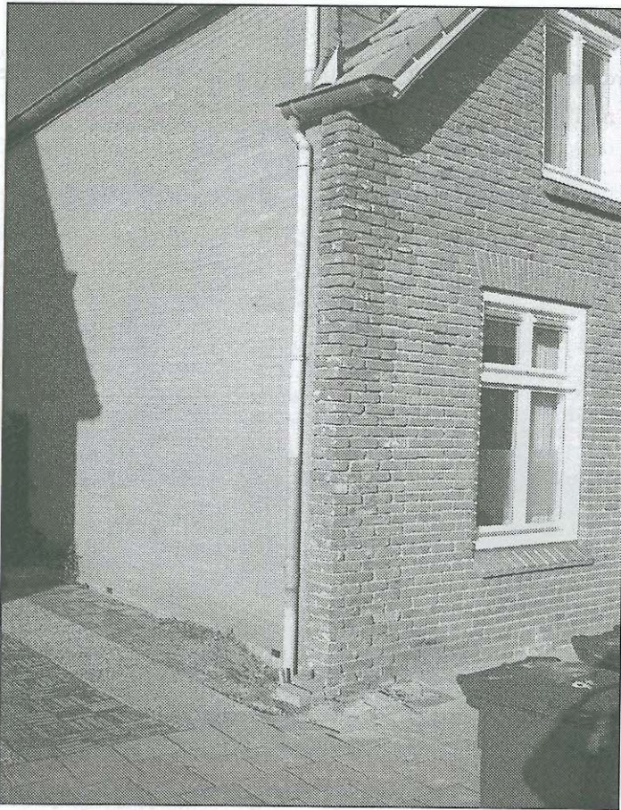
Figuur 8. Duidelijk zichtbaar is dat de gevel een stukje doorloopt; voorheen liep de zijgevel door tot in de voorgevel, waardoor een ander patroon was ontstaan
