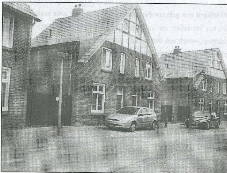
Figuur 7c. De woningen zoals ze er na de casco renovatie uitzien
