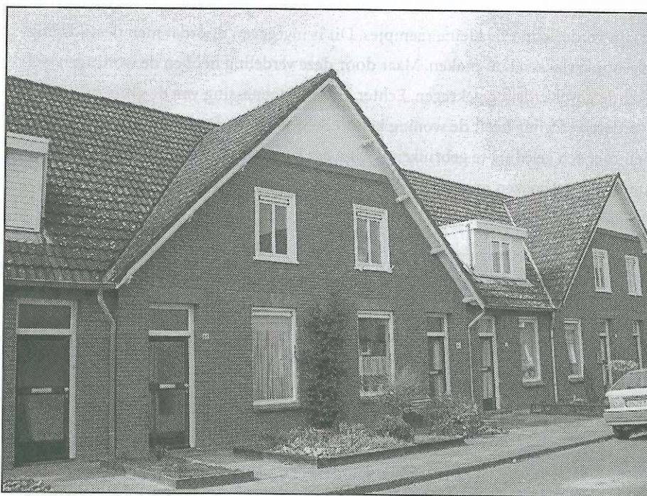
Figuur 5c. De woningen aan de Tenelenweg na de grootonderhoudsbeurt van 2003
