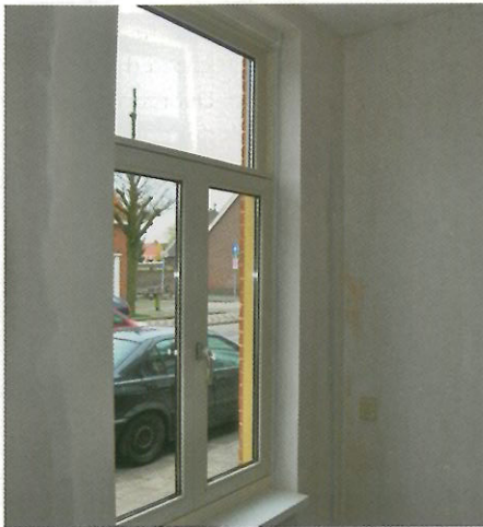
De kozijnen worden vastgeklikt in stelkozijnen. De negge wordt afgewerkt met Werdi-plaat.
