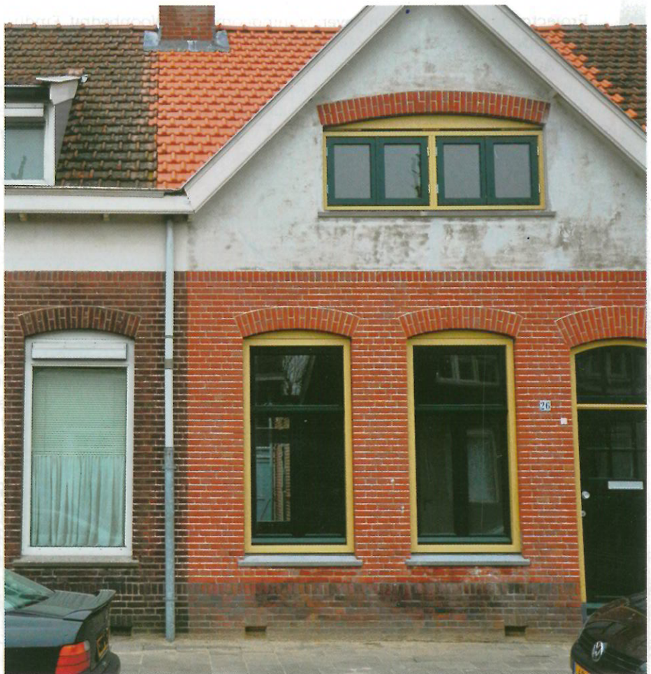
Een proefwoning met ‘schuiframen’ die in werkelijkheid draai-kiepramen zijn. Het ontsierende rooster is vervangen door een ventilatievoorziening in en achter de bovendorpel.
