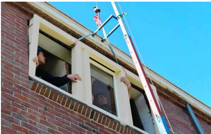
4 Het oude kozijn wordt verwijderd. Een nieuw montagekader wordt aangebracht en het kozijn wordt met een speciale hijsinrichting op zijn plek getild.
